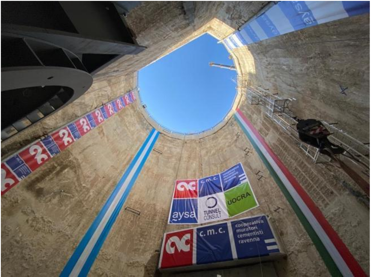
Argentina, Tunnel Idraulico Rio Subterraneo a Lomas (AYSA)
